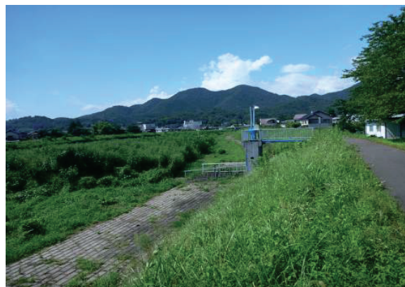
写真-3 試験箇所9.0 km付近の景観 (2014/9/2撮影)。
