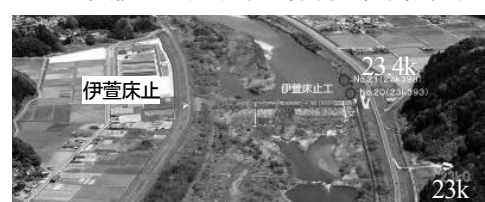
写真-1 伊萱床止め(平成23年撮影).23.3k
