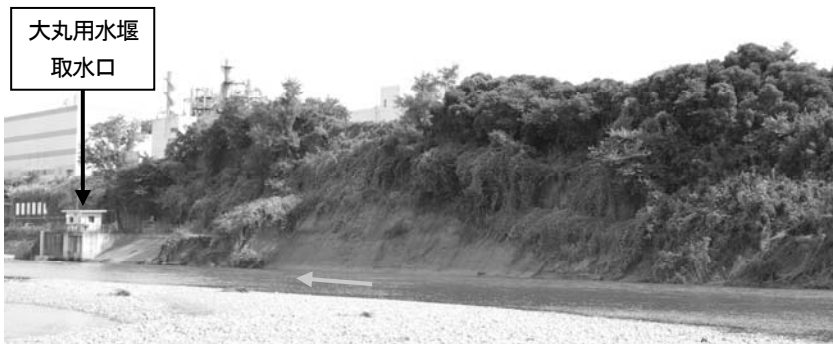
図-5 大丸用水堰上流の河岸侵食状況
