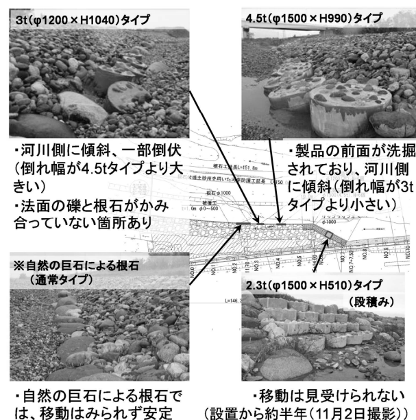
図-9 自然石＋コンクリートのモニタリング結果
