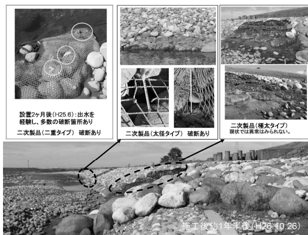
図-8 自然石＋袋詰めネットのモニタリング結果
