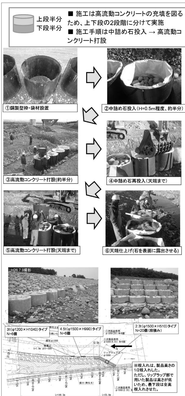
図-6 自然石+コンクリートの製作・試験施工
