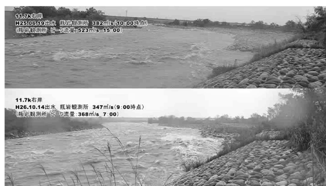
図-11 H25年6月出水とH26年10月出水( Q=367.9\text{m}^3/\text{s} )のリップラップ部の状況
