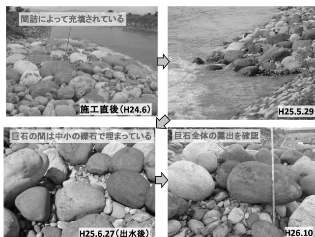
図-10 リップラップ背面部の巨石の移動状況
