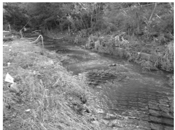
図-11 ネット設置区間において出水後にみられた波状地形
