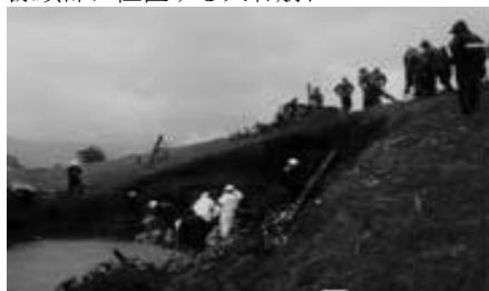
写真-2 偏流による堤防一部流出（S57年8月洪水）。
