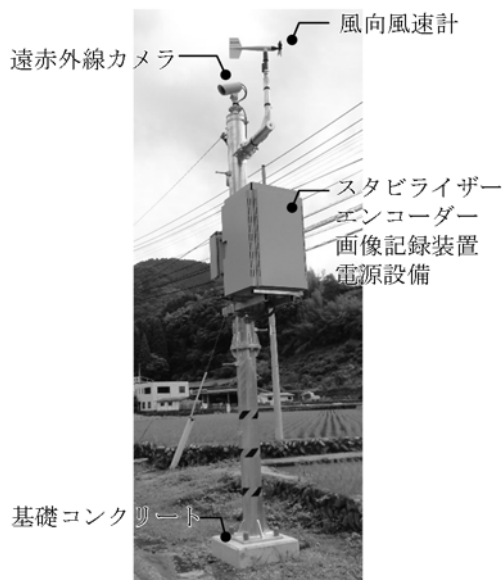
図-4 遠赤外線カメラによる流量観測システム (山国川水系山国川 柿坂観測所)
