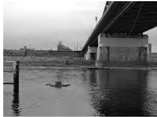
図-3 橋上操作による ADCP 流量観測風景（10 月 8 日忠節地点）
