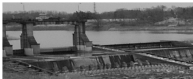
図-1 堰直下の段差発生事例
