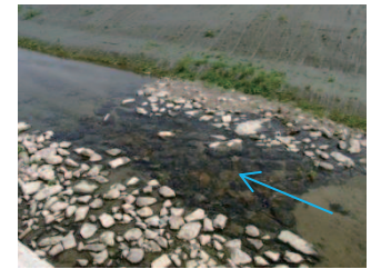
写真-2 早瀬工施工事例 12)
