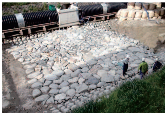
写真-4 早瀬工(H25 施工)
