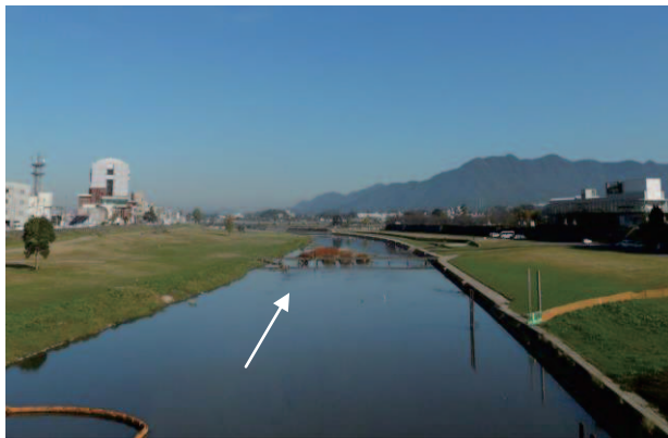
写真-1 遠賀川の船底形河道
