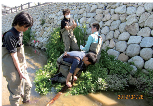
図-6 間伐材水制の施工
