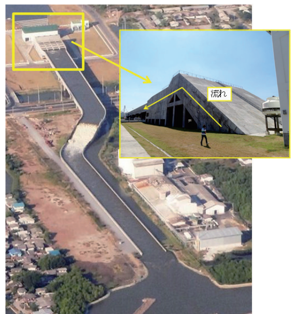
図-3 海岸付近に設置された高架型農業用水路
