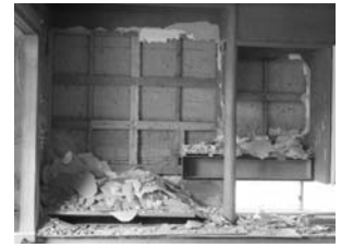
図-6 撤去中の内壁
