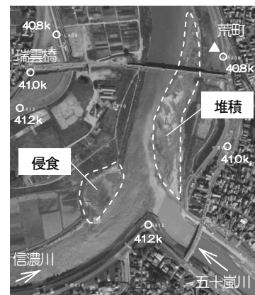
写真-1 洪水後の状況
