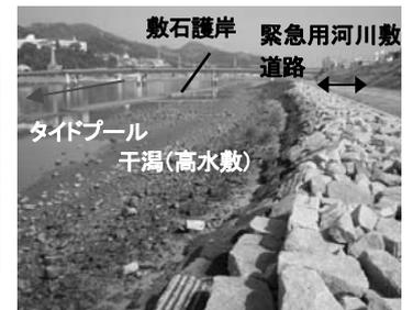
図-5 太田川放水路の0.2kmより上流区間の敷石護岸と緊急用河川敷道路(タイプ2干潟)
