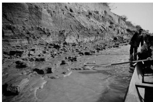
写真-2 露出した泥岩層 (1998年2月)
