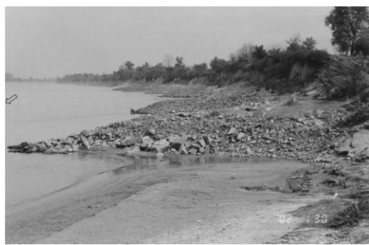
写真-7 建設中の水制群と堆積土砂（2002年1月）
