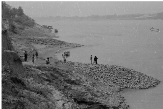
写真-6 完成した1, 2, 3, 4号基（2000年4月）
