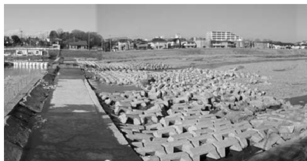
図-4 平山床固下流護床工出水後の状態
