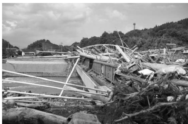
写真-3 阿蔵新橋に集積した流木
