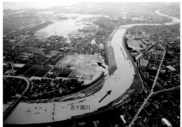
図-1 五十嵐川の破堤写真 3)
