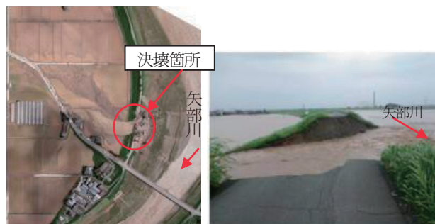
写真-1 右岸7.3K付近の堤防決壊の状況
