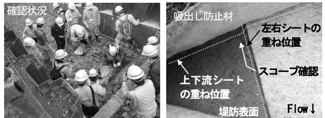
写真-4 鉄線籠下の隙間流の発生状況確認
