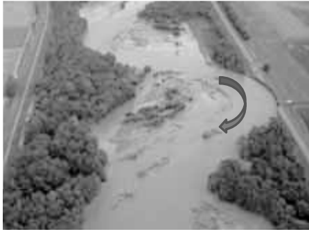
図-1 河岸浸食による堤防流出
