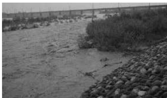
写真-3 洪水時(流量580m³/s) 巨石付き盛土砂州を用いた河岸防護工 (2012. 5撮影)
