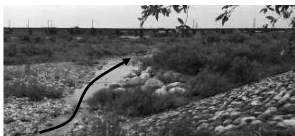
写真-4 現在4年が経過した巨石付き盛土砂州を用いた河岸防護工 (2012. 6撮影)
