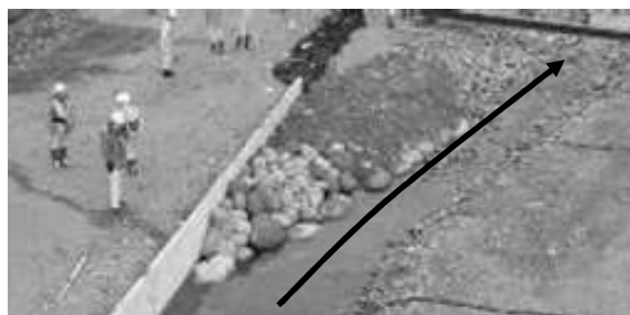
写真-11 水衝部②1 回目通水後巨石付き盛土砂州の設置
