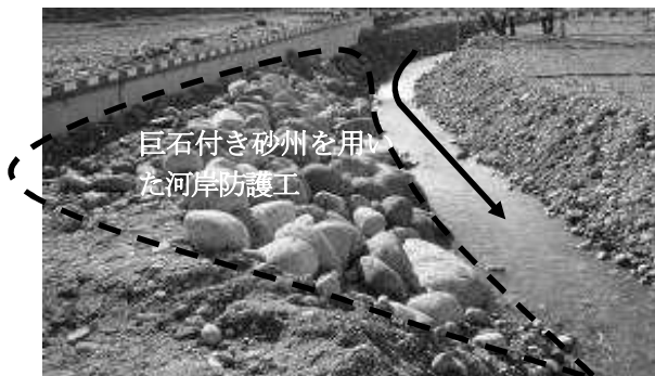
写真-7 水衝部①の巨石付き盛土砂州通水前
