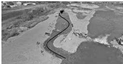
写真-6 1回目通水中の実験水路航空写真
