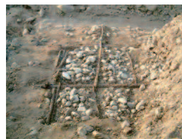
図-8 「二の刎」底部の松製洞木
