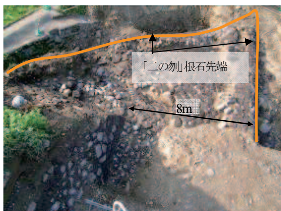
図-6 「二の刎」後端の開口部と根石
