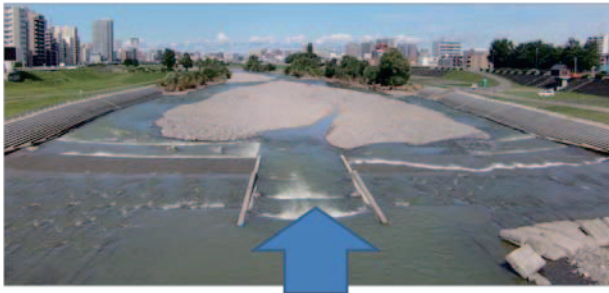
写真-3 H23出水後6.7号床止下流部の堆積状況
