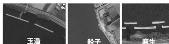
図-2 各実験地の消波構造物設置状況
