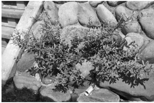
写真-8 1年目の状況 (2009. 09. 16 撮影)
