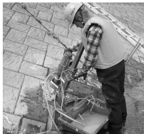
写真-1 護岸への穿孔方法（改良後）
