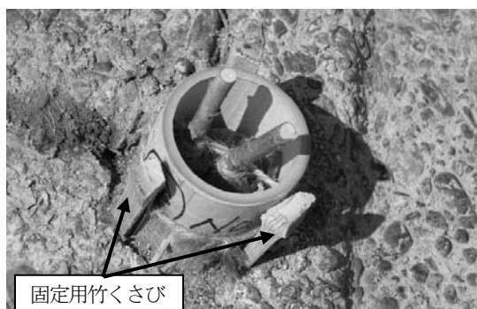
写真-5 竹ポット構造体の竹くさびによる一次固定
