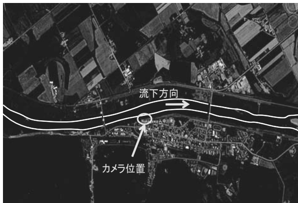
図-3 天塩川菅平水位観測所での映像撮影地点
