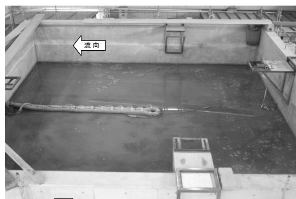
（排砂管の設置状況、給水前）
