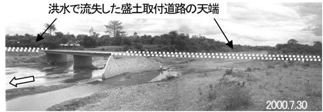
写真-1 ニカラグア国道 24 号線エル・ガジョ橋の被災状況
