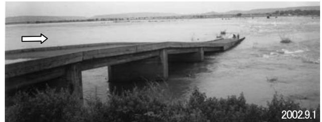
写真-11 同上潜り橋で、雨季に越流されている様子
