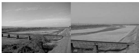
(事業実施前) (事業実施後) 写真-4 低水路付け替え前後の状況
