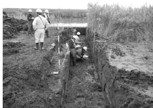
写-1 開削状況と各種測定風景 (2010. 11. 30)
