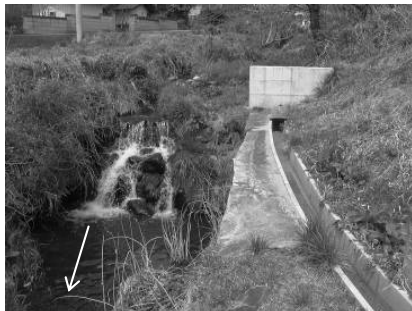
写真-1 改修前の取水施設
