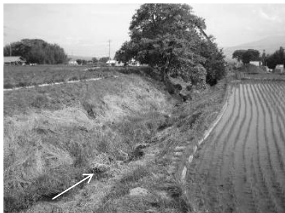
写真-2 改修前の河道状況
