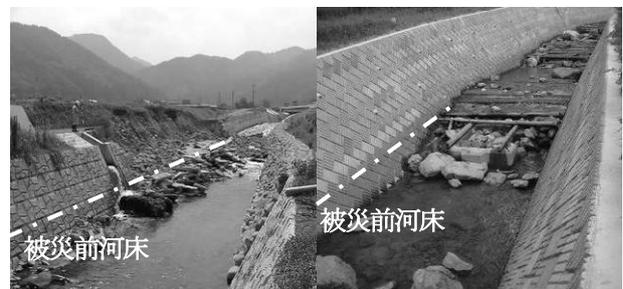
写真-1 改修後の中小急流河川における河道災害の例
