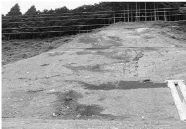
写真-1 斜面切り取り部の水ミチの路頭
