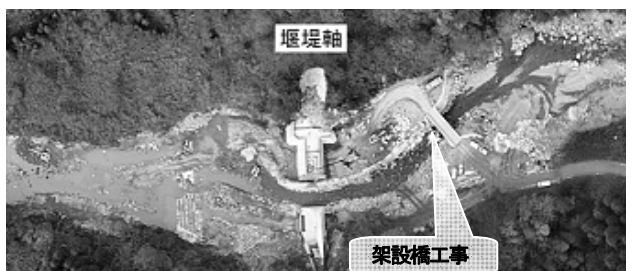
写真-5 尾添における架設橋工事
