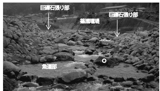
写真-5 工事完成直後, 5年後流失した力石 (2005年10月)
