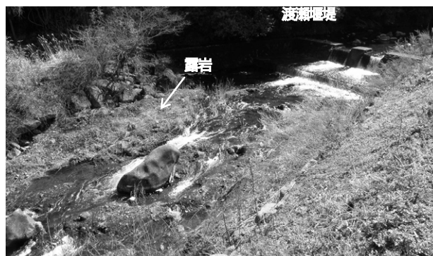
写真-12 渡瀬堰堤直下の全面露岩河床 (2010年2月)
