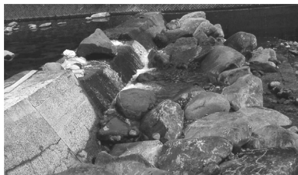
写真-3 工事中の堰堤直下石組み構造 (2005 年 1 月)
