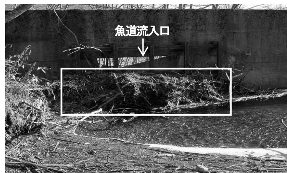
写真-2 流木が堆積した魚道流入口上流部
