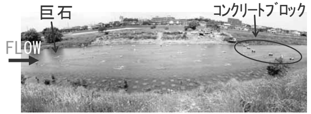
写真-1 実験区設置後状況（設置直後 右岸堤防上から撮影）
