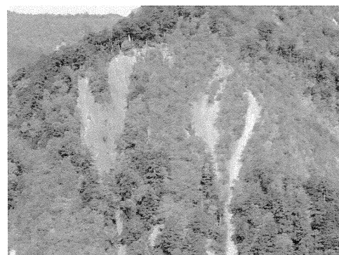
写真-1 流域内の斜面崩壊
