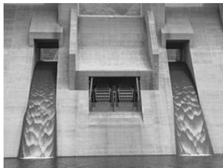
図-2 灰塚ダムの常用洪水吐き（両脇）と環境用水放流設備（中央）
