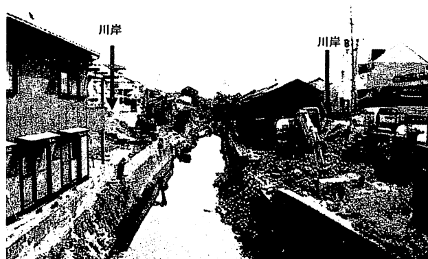
写真-1 中橋下流の河道内住宅 (2008. 10. 08撮影)
