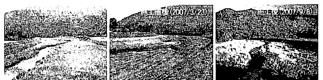
写真-5 砂州切り下げ (施工前・施工直後・施工後)
