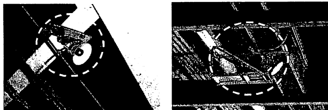
写真-1 ドップラー式流速計の設置例 (超音波流速計(左), 電波流速計(右))
