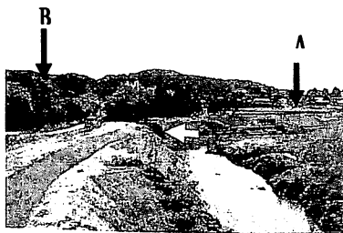
写真-17 花見滝橋から上流方向を望む
