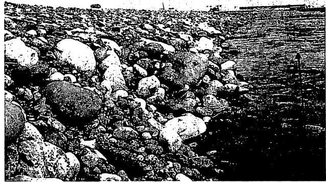
(b) 最も法面の崩落が見られた箇所
