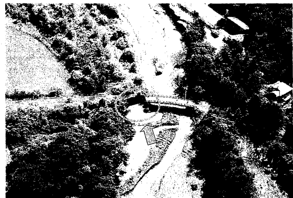
写真-9 流木による河道閉塞のため橋台背後が侵食された例（北海道居辺川居辺橋、2003年の北海道水害時）
