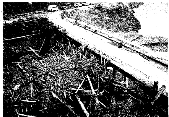
写真-8 大量の流木・塵芥で閉塞した橋梁（宮崎県日向土木事務所提供）
