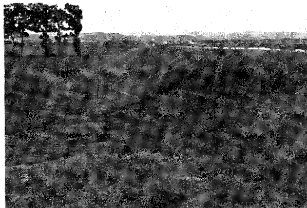
写真-1 No. 7地点被災状況
